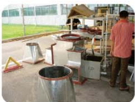
排风管道制作现场
