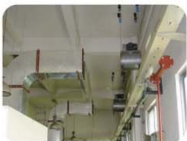
排风管道改造过程中
