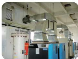
改造完成后的排风管道
